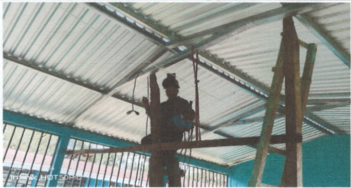
Foto1: Suministro e Instalación de estructura metalica tipo portico
