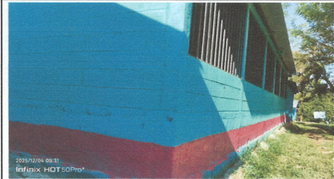
Foto1: Suministro e Instalación de columnas de concreto
