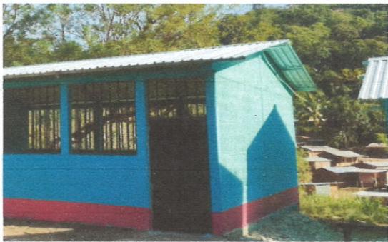
Foto 5: Suministro e instalación de puertas metalicas
