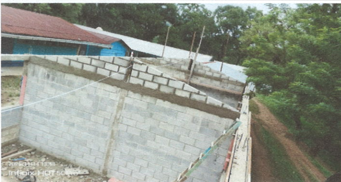
Foto 3: Suministro e instalación de paredes de Block
