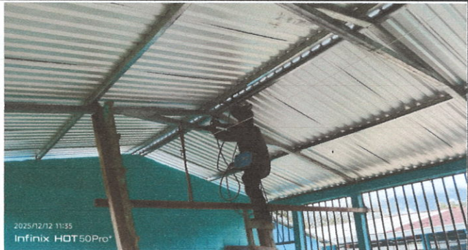
Foto 2: Suministro e instalación de techo con lamina troquelada
